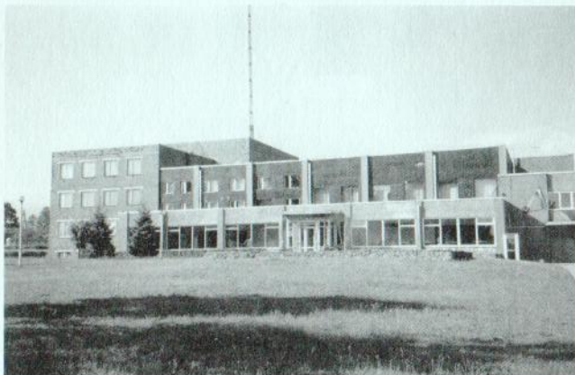
Limbažu raj. Lēdurga, E.Melngaiļa ielā 2a Arhitekts G.Roops 1975.-1982.g.
