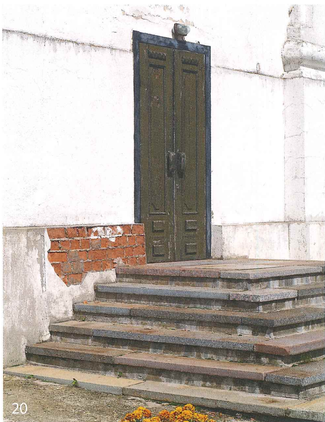
Pamācoši piemēri: durvis, kas izvirzās ārpus fasādes, nekalpos labi un ilgi, fasādes izvirzījumi bez lāseņiem drīz noplūks, cements senceltnes apmetumā ir garantija, kas tas drīz nokritīs. Pamatu apbetonējums laika gaitā atdalās no fasādes un ūdens tek pret pamatiem, nevis prom.
