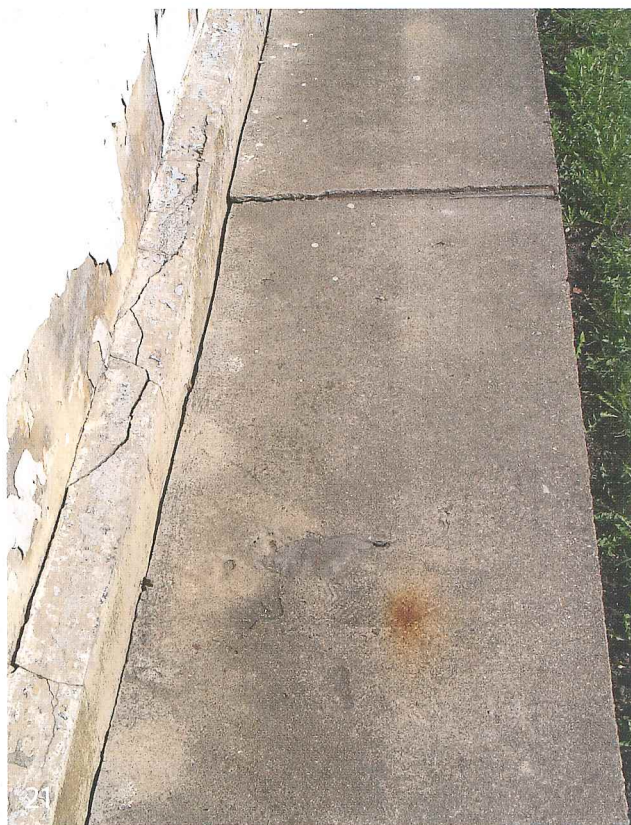
Pamācoši piemēri: durvis, kas izvirzās ārpus fasādes, nekalpos labi un ilgi, fasādes izvirzījumi bez lāseņiem drīz noplūks, cements senceltnes apmetumā ir garantija, kas tas drīz nokritīs. Pamatu apbetonējums laika gaitā atdalās no fasādes un ūdens tek pret pamatiem, nevis prom.
