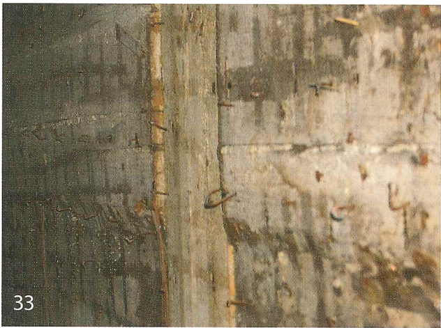
19. gs. koka sienas virsma pēc apmetuma noņemšanas.
