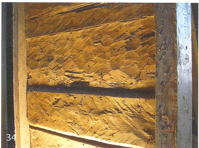
Tā pati siena pēc mazgāšanas, caurumu tapošanas, slīpēšanas ar smalku dzelzs vati, vaskošanas dzīvojamās mājas interjerā Ķīpsalā.
