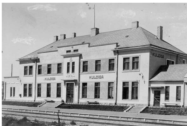
Kuldīgas dzelzceļa stacijas ēka.
